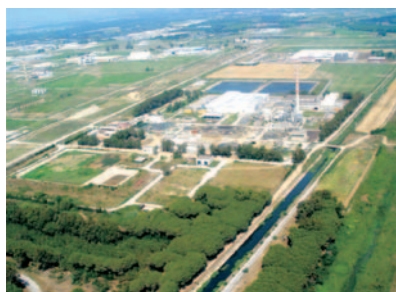
Impianti di trattamento
